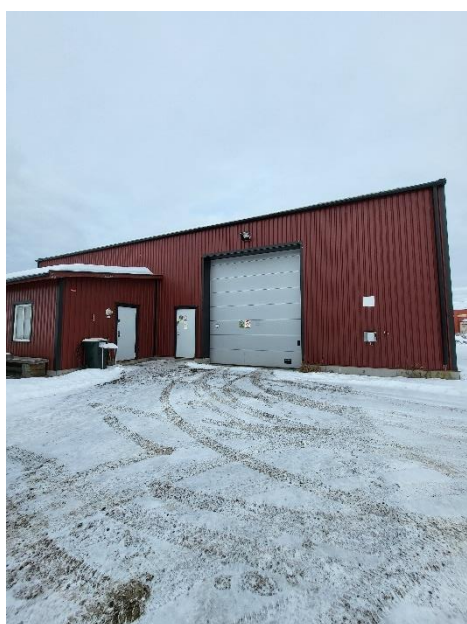
Figur 13. Foto byggnad 8, utsidan.
