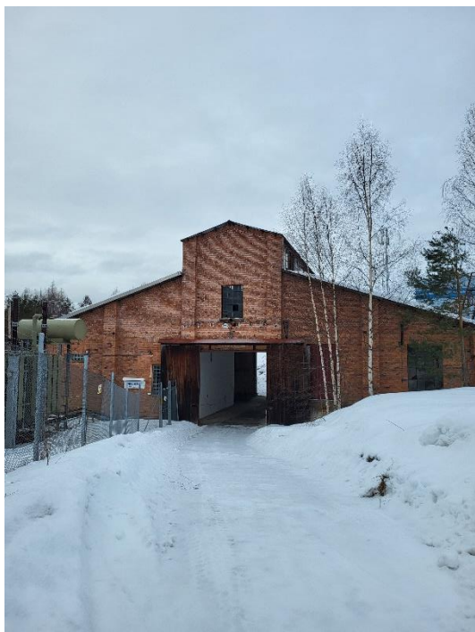
Figur 14. Foto byggnad 9, utsidan.
