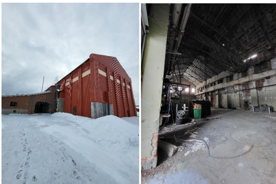
Figur 12. Foton byggnad 7, utsidan och insidan.
