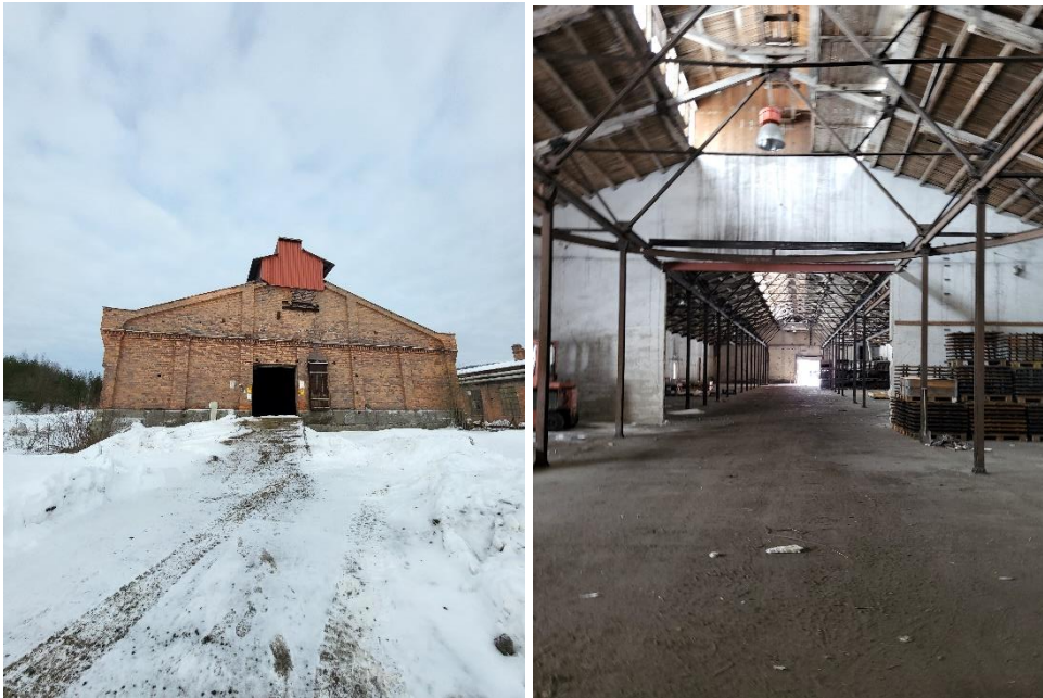
Figur 10. Foton byggnad 5, utsidan och insidan.
