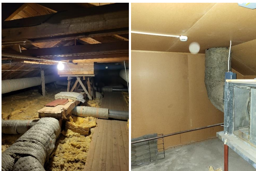
Figur 4. Foton byggnad 1, vindsutrymme.
