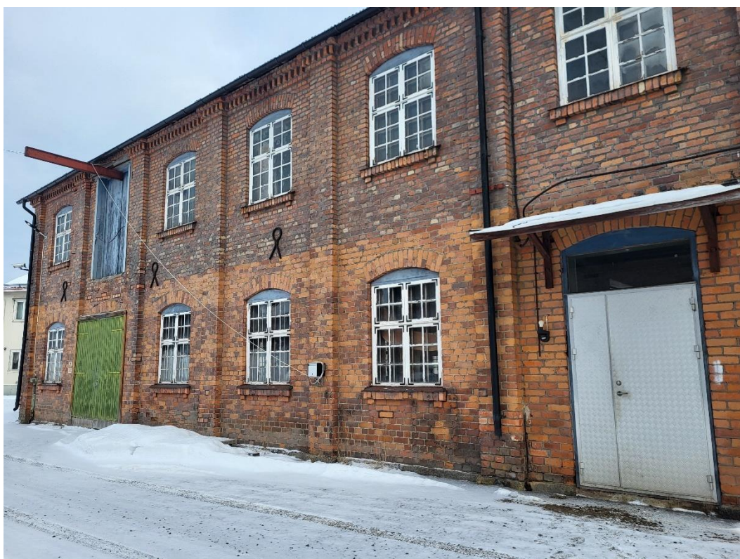
Figur 5. Foto byggnad 2, utsidan.
