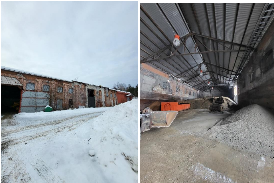
Figur 11. Foton byggnad 6, utsidan och insidan.
