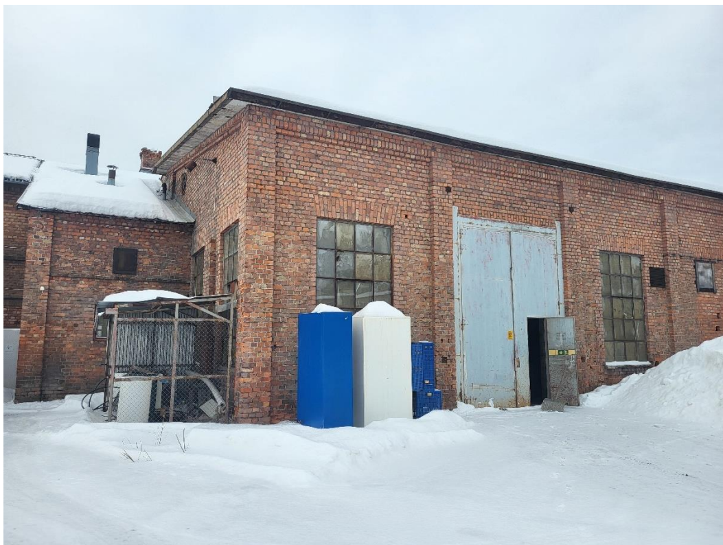
Figur 7. Foto byggnad 3, utsidan.
