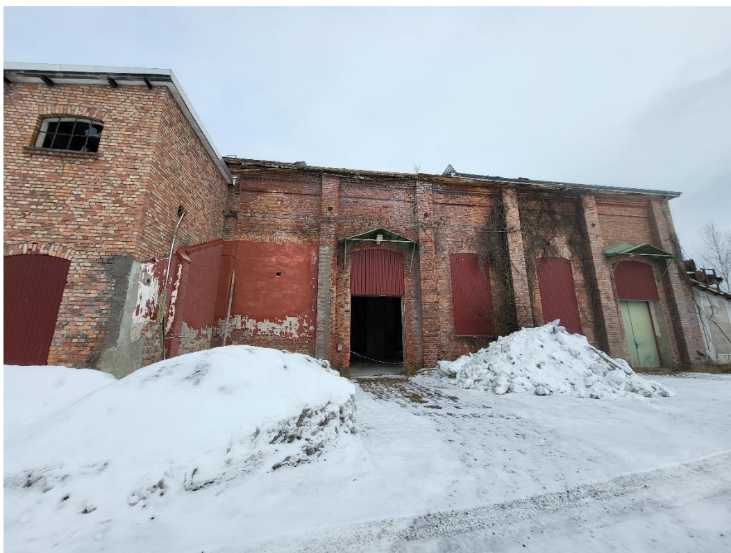
Figur 15. Foto byggnad 10, utsidan.
