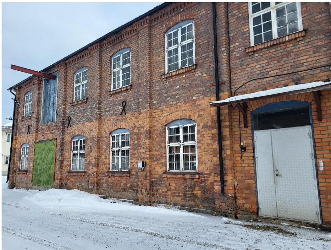
Figur 5. Foto byggnad 2, utsidan.
