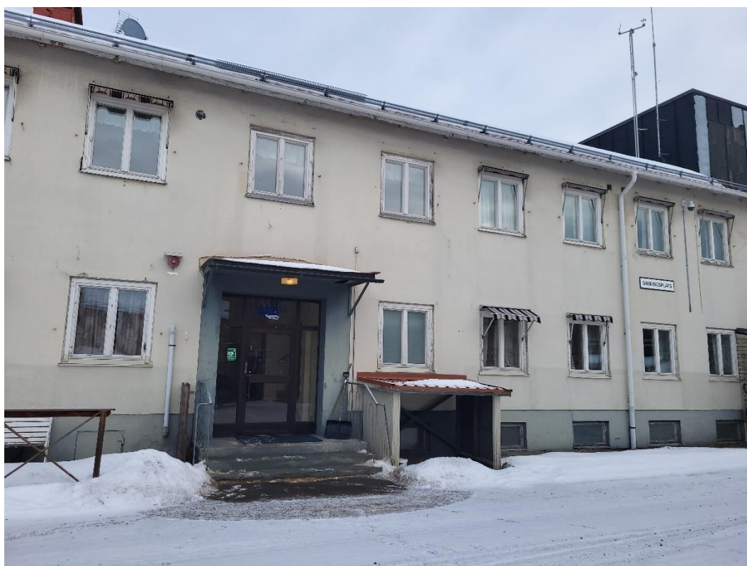
Figur 3. Foto byggnad 1, utsida.
