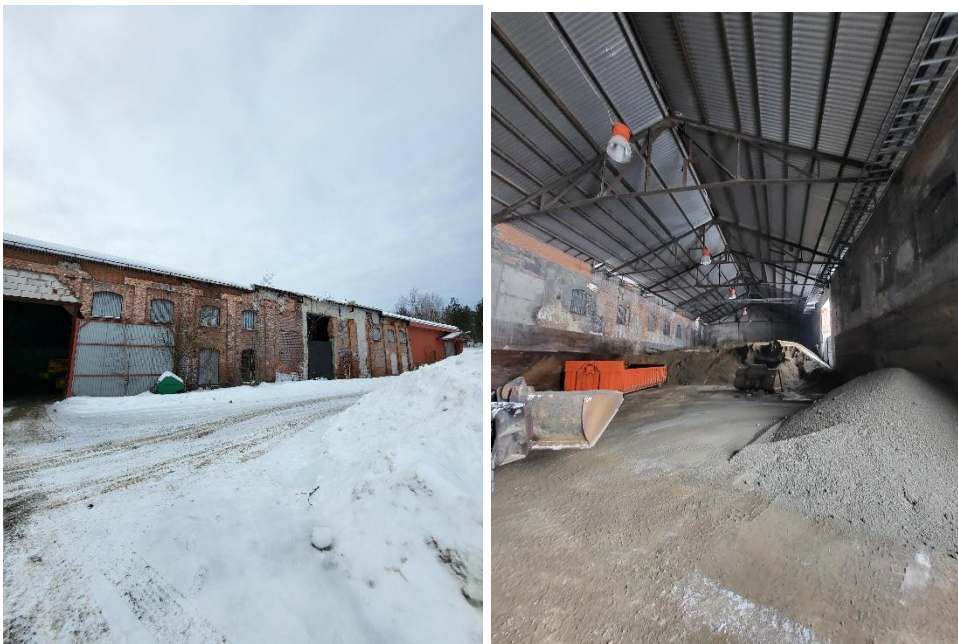
Figur 11. Foton byggnad 6, utsidan och insidan.
