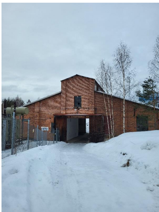
Figur 14. Foto byggnad 9, utsidan.
