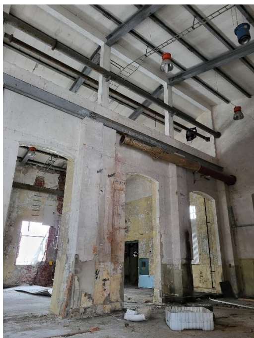
Figur 16. Foto byggnad 10, insidan.
