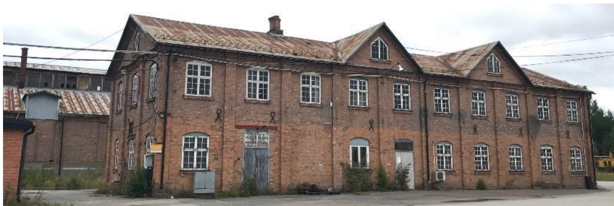
Figur 3. Industribyggnad 1910-tal, Ljungaverk. Rapport YLM 2023:7.
